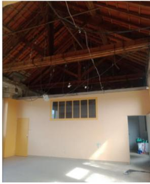
Pas de travaux sans mauvaise surprise... ! Le démontage du faux plafond nous a montré que la charpente devait être traitée et renforcée soit un surcoût de 9 000€ ...
