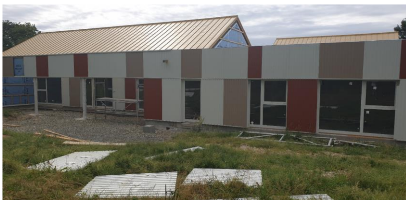
Vu de derrière, à gauche salles d'activités avec préau, à droite salle de motricité
