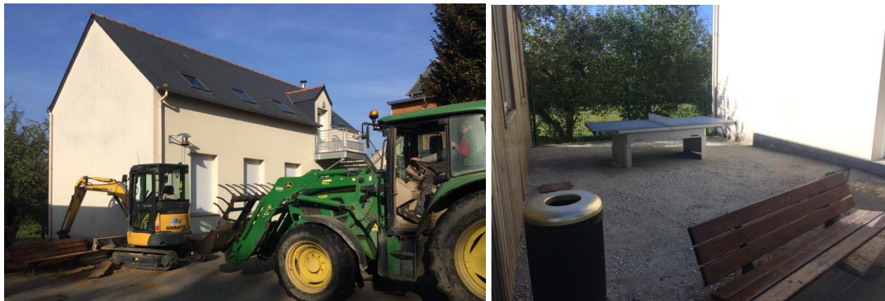
Terrassement pour mise en place prochaine d'un enrobé pour l'emplacement de la table de ping-pong
