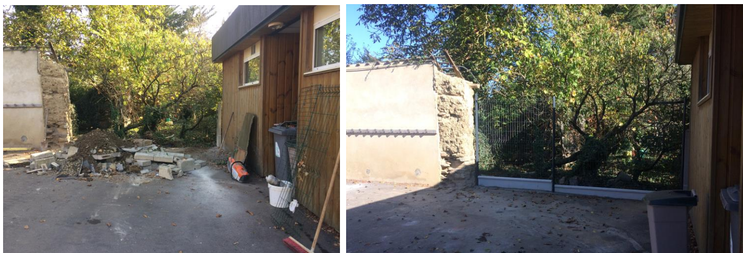
Démolition d'un ancien mur en parpaing et remplacement par du grillage rigide
